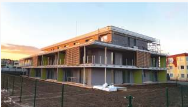
výstavba bytového domu Vestecké Terasy
