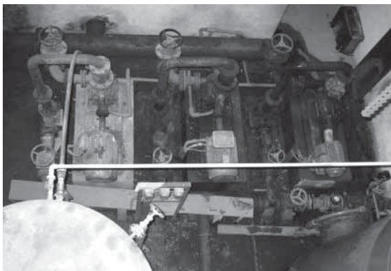
ATS před rekonstrukcí
