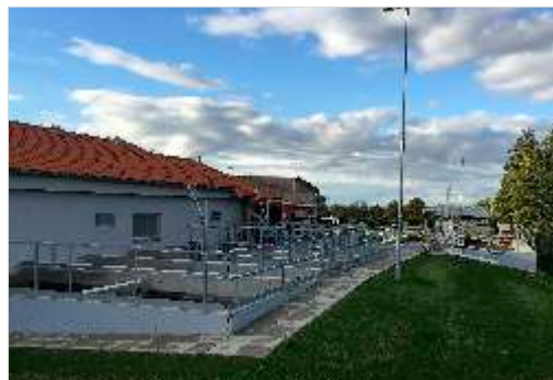
Nádrže denitrifikace, zde se dusičnany mění na elementární dusík.
