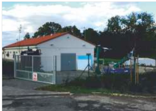
Pohled na ČOV Vestec z ulice K Jahodárně.
