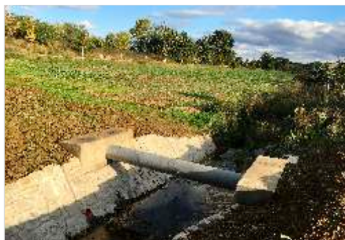
Upravené koryto Olšanského potoka, nové potrubí nahradilo starou shybku pod potokem.
