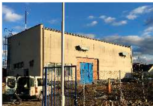
Stavební práce na objektu automatické tlakové stanice. Z tohoto místa je voda dodávána do celé obce.
