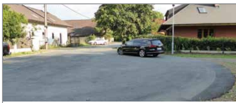
Ulice K Rybníku s novým asfaltem.
