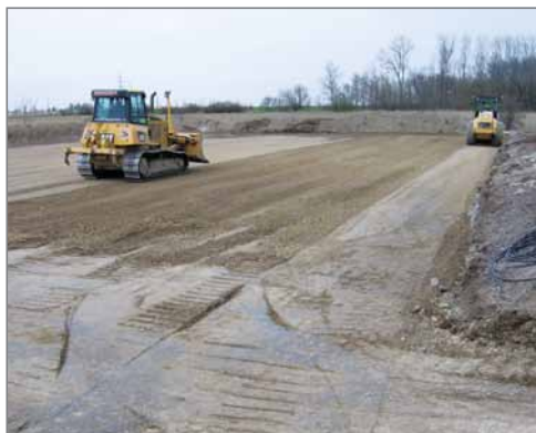
Přípravy na stavbu přístavby MŠ.
