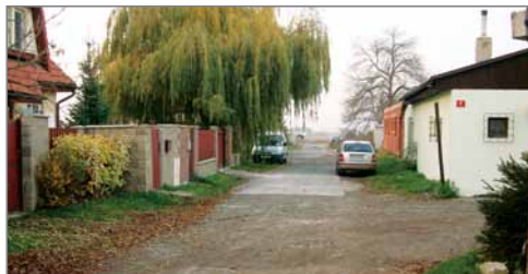
Ulice U Hřiště před rekonstrukcí.
