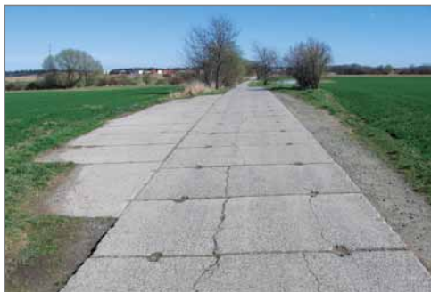
Ulice Na Skále s původní panelkou.
