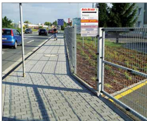
Nově zbudovaný chodník a oplocení.
