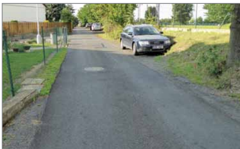
Ulice K Vodárně po opravě.
