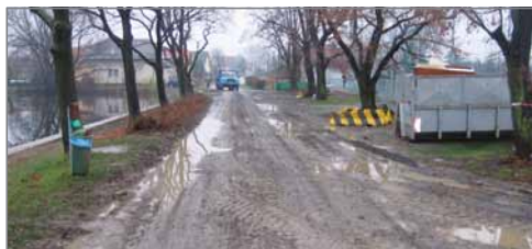
Hráz rybníka před opravou.
