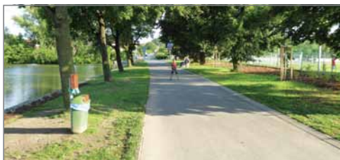
Hráz rybníka po opravě.
