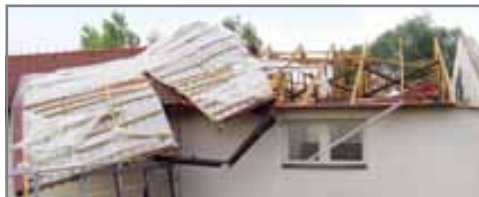
Poškozená čistírna odpadních vod.
