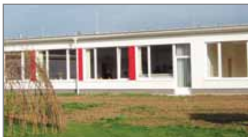
Přístavba nové mateřské školy.
