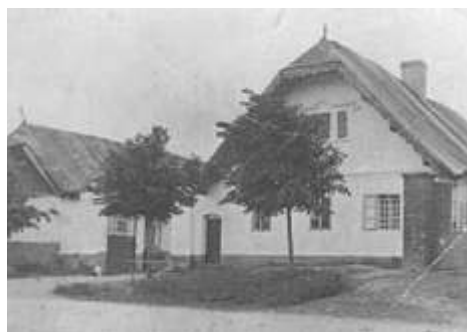
Dům č. 12 na Vestecké ulici, dnes je zde cukrárna
