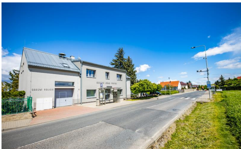
Obrázek 1 – Budova obecního úřadu a obecní policie, Vestecká 3.
