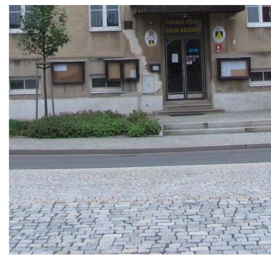
sířidání povrchů žulové dlažby a asfaltu
