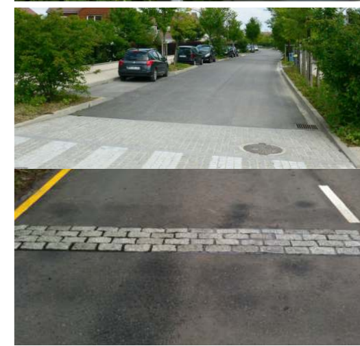
retardér - pás žulových kostek přecházející z okolních chodníků
