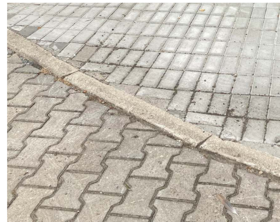
přechod různých tvarů zámkové dlažby
