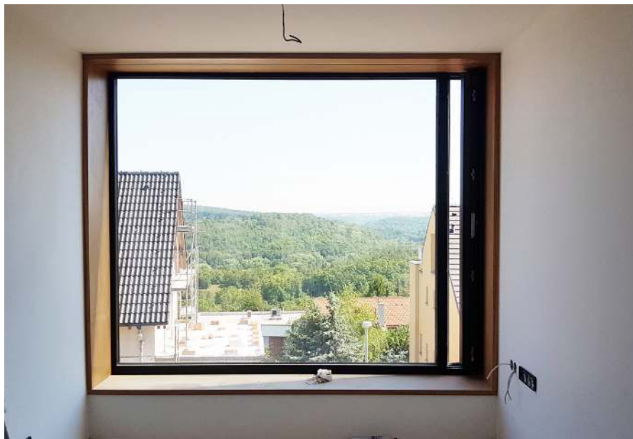
Fixní okno s křídlem z plného panelu, využíváno pro štěrbinové větrání.
