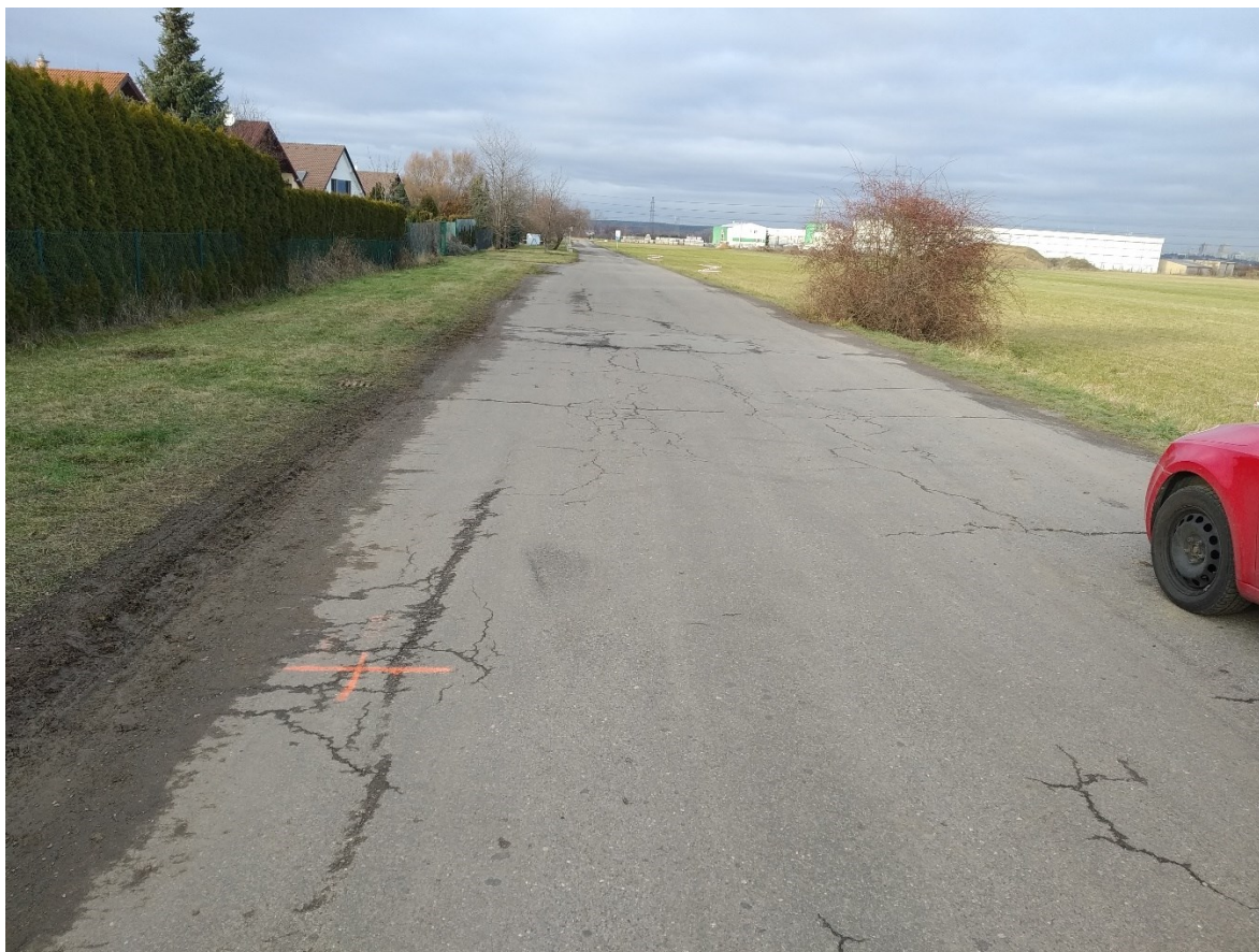
Obrázek 3 - Ulice K Jahodárně před rekonstrukcí, 3. 1. 2022.
