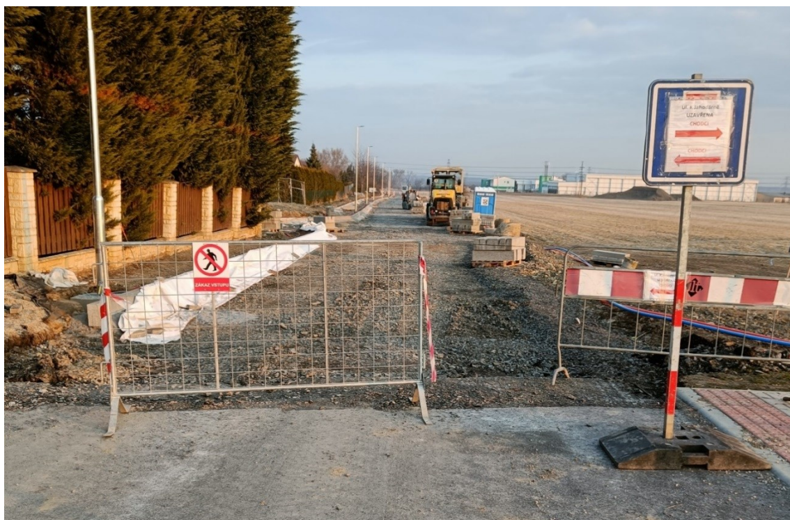
Obrázek 4 - Ulice K Jahodárně v rekonstrukci, 19. 3. 2022.
