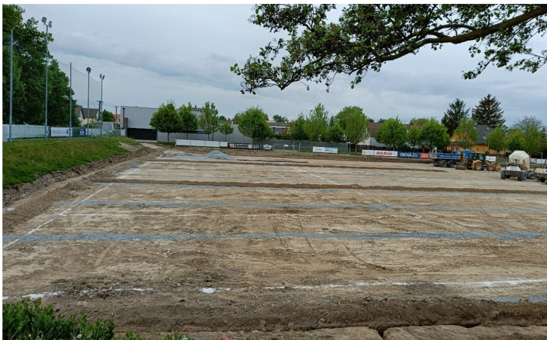
Obrázek 5 - Fotbalové hřiště v rekonstrukci, 13. 5. 2022
